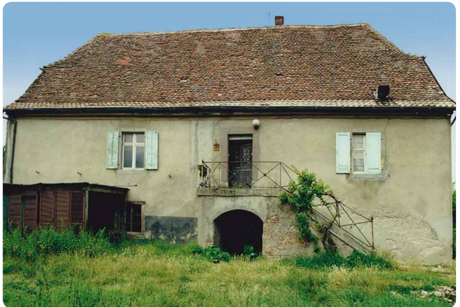
La maison dîmière avant sa démolition en 1997
